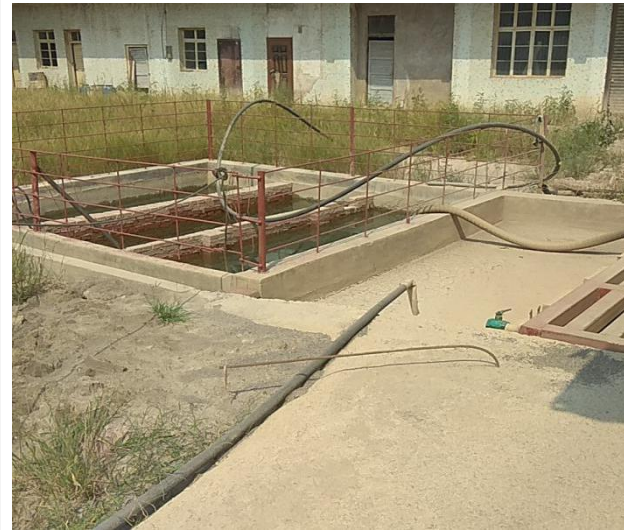
洗车循环水池
